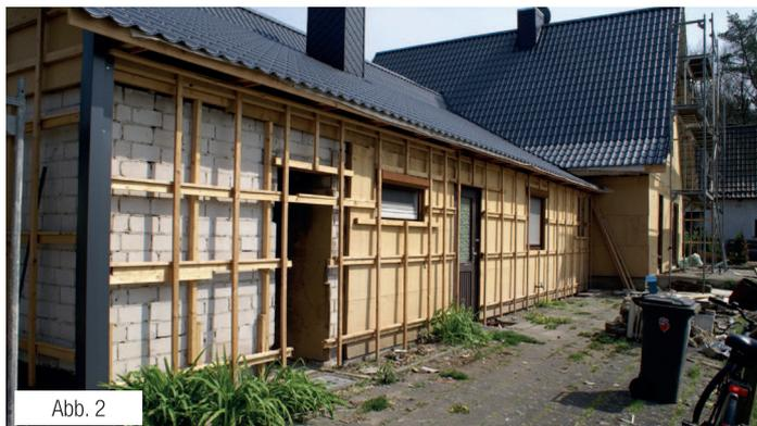
Après la répartition des panneaux de montage, vous commencez le montage de la sous-construction. Prenez en compte les largeurs de support et les écarts maximaux de la sous-construction pour le profilé sinusoidal. Pour le QuickPaneel, l'écart de la sous-construction (écart entre les liteaux) ne doit pas être supérieur à 600 mm.
