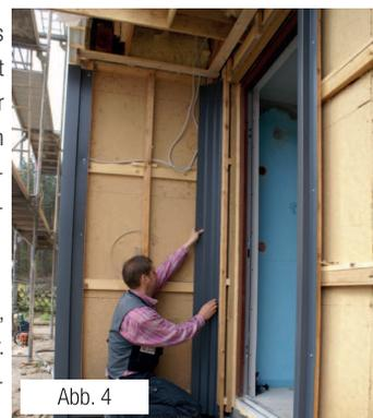
Ensuite, fixez les lésènes de coin extérieur et, le cas échéant, les lésènes de coin intérieur. Veuillez à ce que le montage de toutes les lésènes soient parfaitement perpendiculaires.
