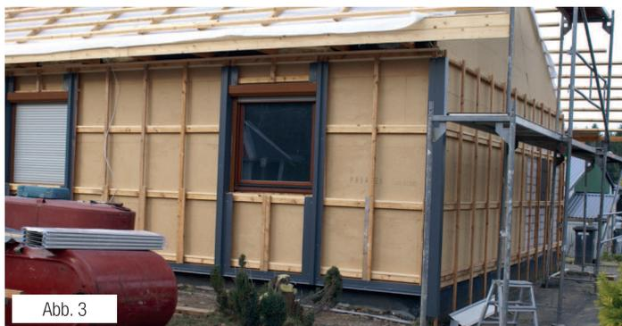
Commencez avec le montage des profilés système (fig. 3/4). Notez que les profilés système tel que le profilé socle, du coin intérieur, du coin extérieur et les lésènes de jonction doivent tout d'abord être maintenus dans la position adaptée avec quelques vis. La fixation
